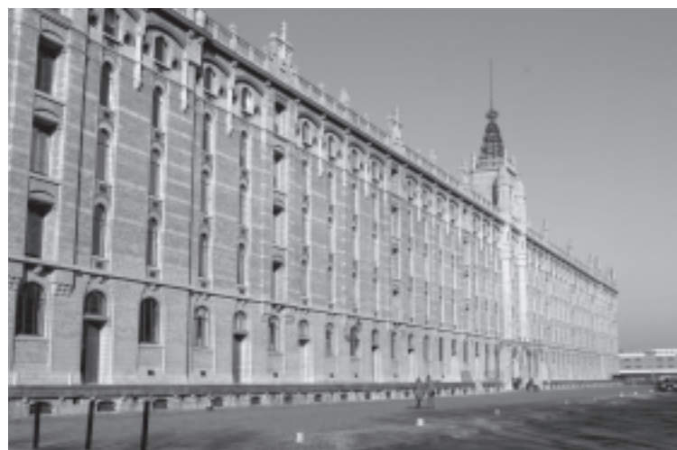
Façade avant de l'entrepôt Royal de Tour et Taxis, rénové en 2004
