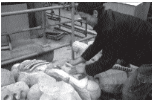
Tailleur de pierre au travail sur le chantier.
